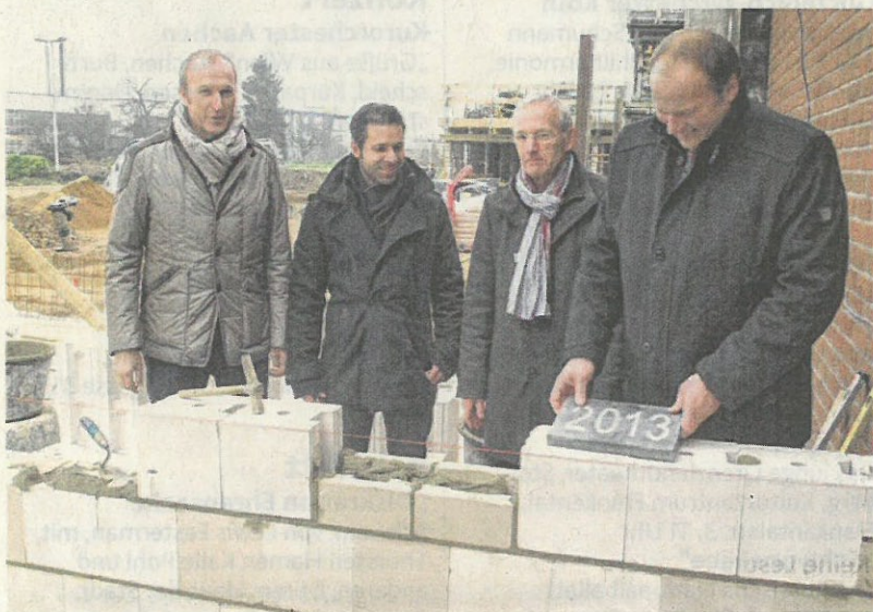
Bürgermeister Bernd Jansen packt gern selbst an, wenn es um Grundsteinlegungen geht – er ist von Haus aus Handwerker. Foto: Koenigs
